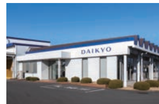
佐野大町工場 Sano Daicho Plant
